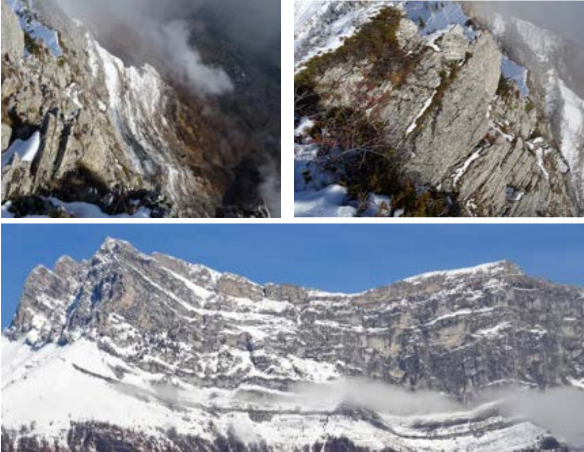
Figure 38: clichés de la couche urgonienne. En haut stratigraphie redressée sujette au phénomène de fauchage, en bas vue globale permettant d'appréhender un affleurement généralement sain.
