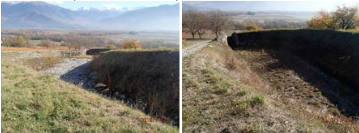
Figure 70: deux casiers successifs de la plage de dépôt
