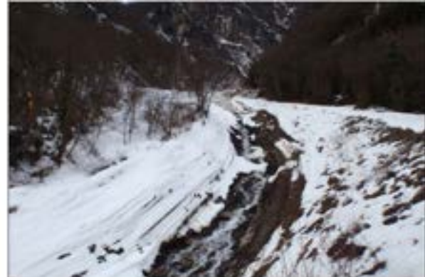
Photo 2 – Coude depuis l'aval
