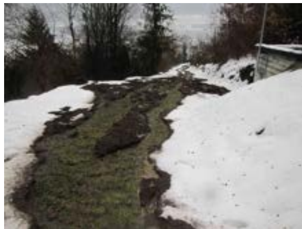
Figure 63: crue du 6 décembre 2010 sur la piste menant au réservoir
